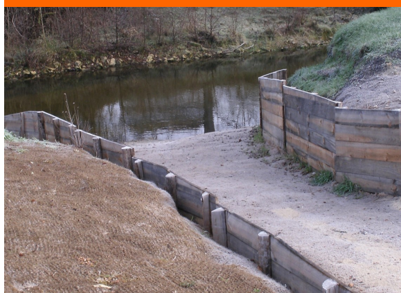
Aménagement de la mise à l'eau pour la base nautique
