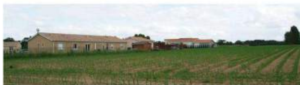
Extensions banalisantes à Bieujac - Source : Atlas des paysages de Gironde
