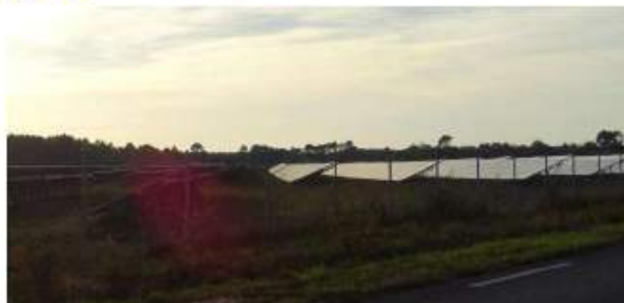
Champs de panneaux photovoltaïques à Hostens - Crédits : Even Conseil
