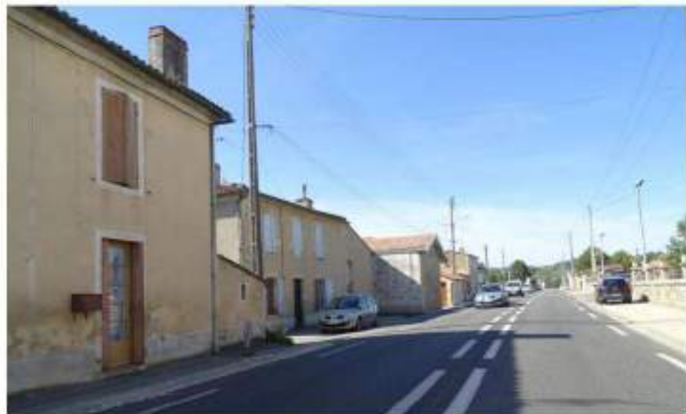
Une traversée de bourg au caractère très routier – St-Maixant - Crédits : Even Conseil
