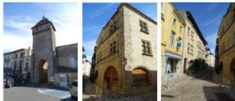
Patrimoine bâti riche de la cité médiévale de St-Macaire - Source : Even Conseil
