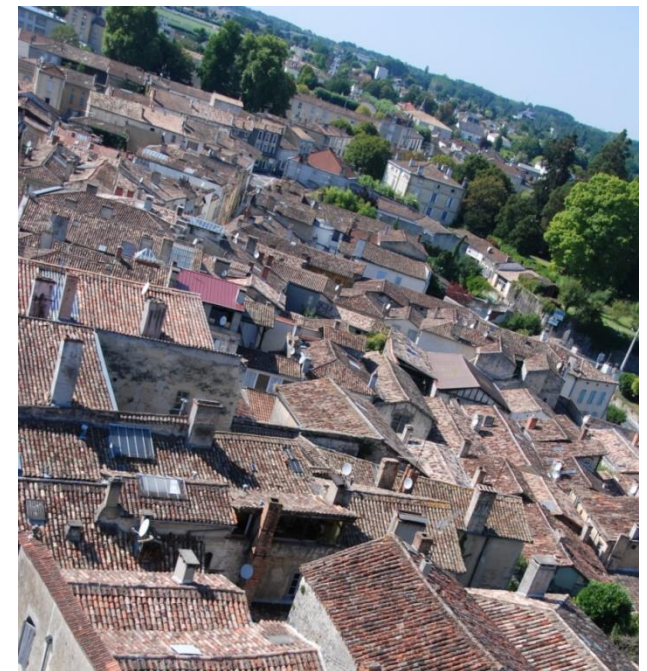
Cité médiévale de Bazas faisant l'objet d'un Site Patrimonial Remarquable - Crédits : Even Conseil
