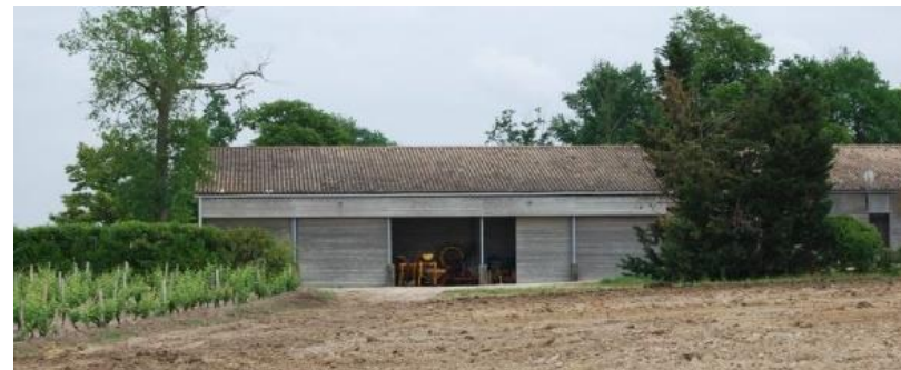
Les bâtiments viticoles plus récents bénéficient également d'une architecture soignée - Sauternes - Crédits : Atlas des paysages de la Gironde
